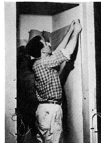
Fig. 12. Vægbeklædning under opsætning. Der kontaktklæbes langs alle kanter og enkeltklæbes på midterpartierne. Efter opsætningen renskæres vægbeklædningen i de rette afstande fra henholdsvis loft og gulv. Vægbeklædningen rulles på i een bane fra rummets ene side. På billedet ses vægbeklædningsrullen i det bageste hjørne af rummet.
