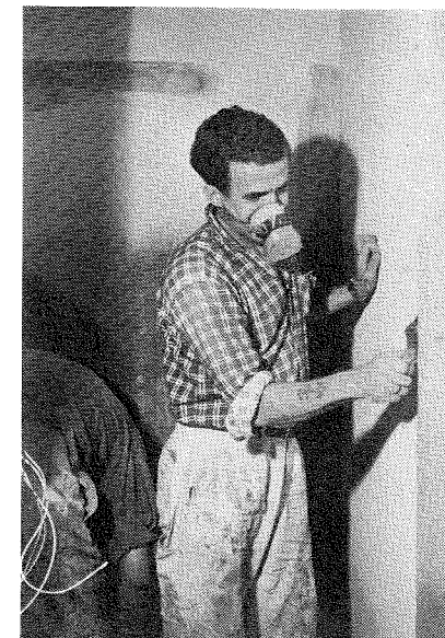
Fig. 3. Kontaktlimene afgiver sundhedsfarlige dampe, hvorfor Arbejdstilsynet forlanger, at der under arbejde bæres en maske med filter.
